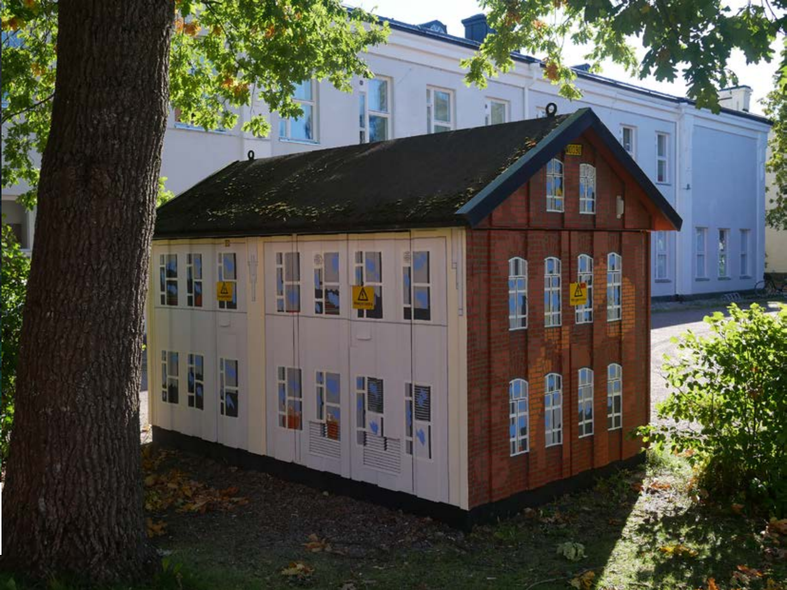
Anni-Sofia Knuuttilan teos Lappeenrannan energian muuntamorakennuksessa Linnoituksen alueella.
